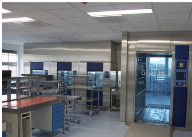
Bereits seit Mitte August kann im neuen Labor und der Zentralsterilisation gearbeitet werden.
